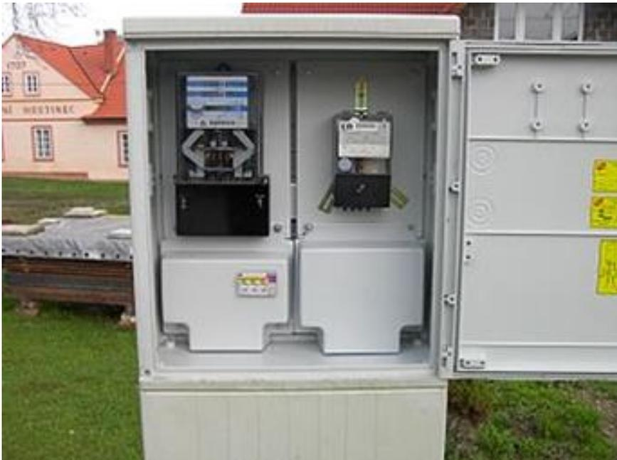
Elektroměrový rozváděč je vždy v majetku majitele odběrného místa. Připojovací podmínky specifikuje distribuční společnost a jsou souborem požadavků, schémat a dalších podmínek pro provedení, umístění a zapojení měřicích souprav a rozváděčů u odběratelů připojených z distribuční sítě.
