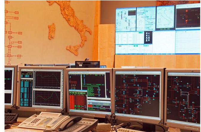
Bild 3: Zentrale Steuerung der Energieverteilung, Terna S.p.A.
